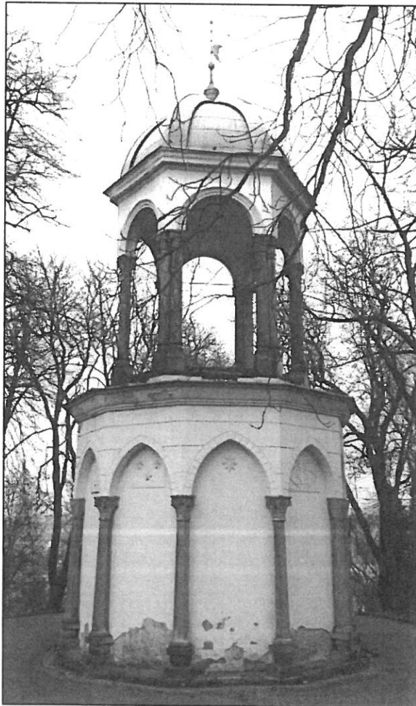
Boží hrob na Petříně v Praze... (foto autor) komplexní obnova ... sanace vlhkosti: vnější větrací kanál, provzdušnění spár vnitřní dlažby, odsolení konstrukcí, prodyšné úpravy stěn (vápenné omítky), obnova přirozeného větrání interiéru, odvodnění přilehlých ploch (odspádování dlažby)
