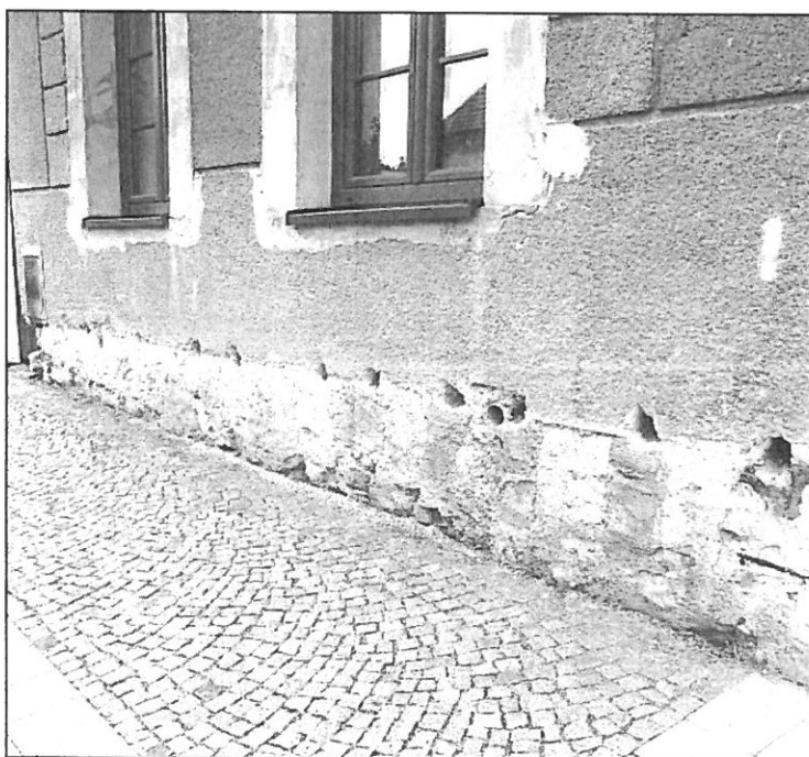
Injektážní vrty (foto autor)
