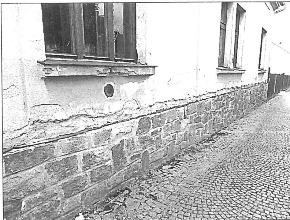
Hydroizolace do pod bourané drážky (foto autor)
