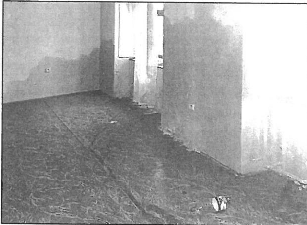
Měšťanský dům v Telči (foto autor, nový stav Ladislav Bezděk) ... komplexní obnova ... sanace vlhkosti: odsolení konstrukcí, prodyšná úpravy fasády (vápenné omítky), odvod dešťové vody, vnitřní větrací kanál propojený s větranou podlahou, prodyšné úpravy stěn (vápenné omítky)
